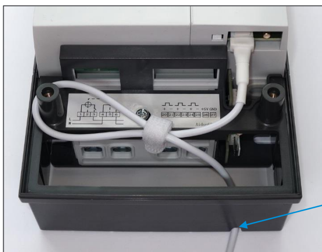
Figur 14: Kabelinstallasjon for 1-fase måler med langt deksel.
